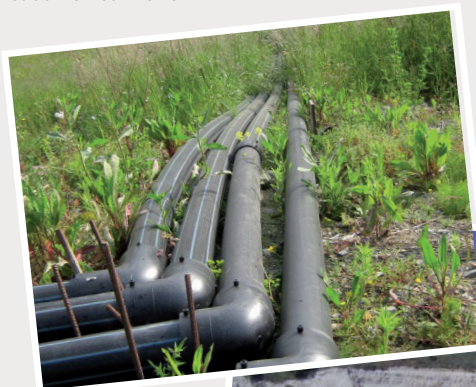
Detalle mejora red desgasificación (Vertedero San Marcos, País Vasco)
