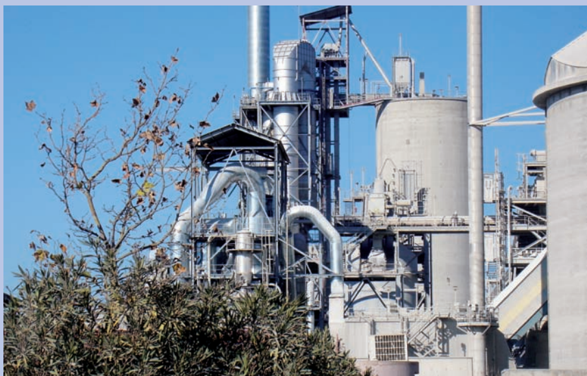
El Alto Cement Factory, Morata de Tajuña, Madrid
