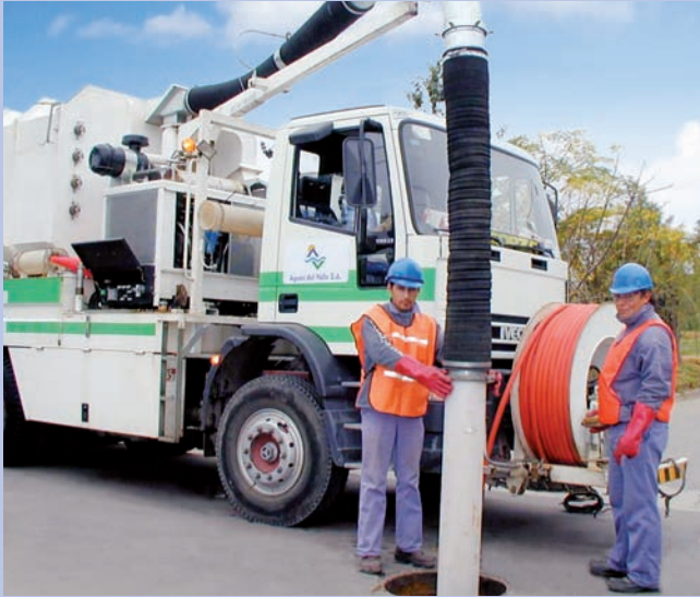
Drain cleaning. Aguas del Valle. Argentina
