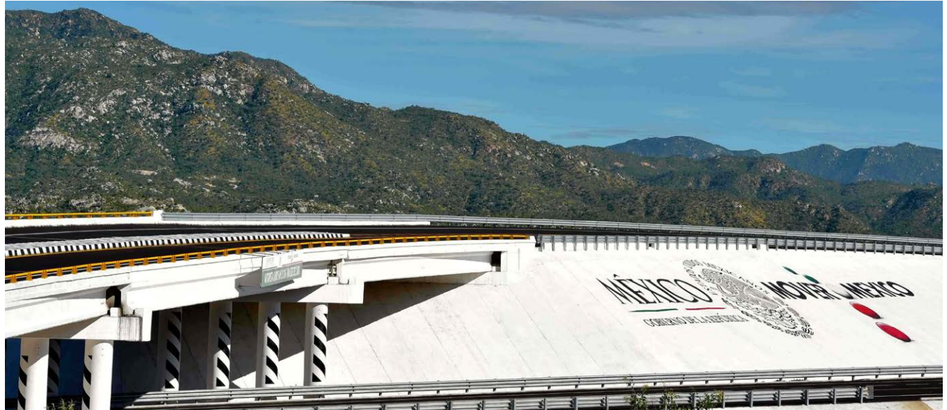
San José del Cabo - Cabo San Lucas motorway (Mexico).
