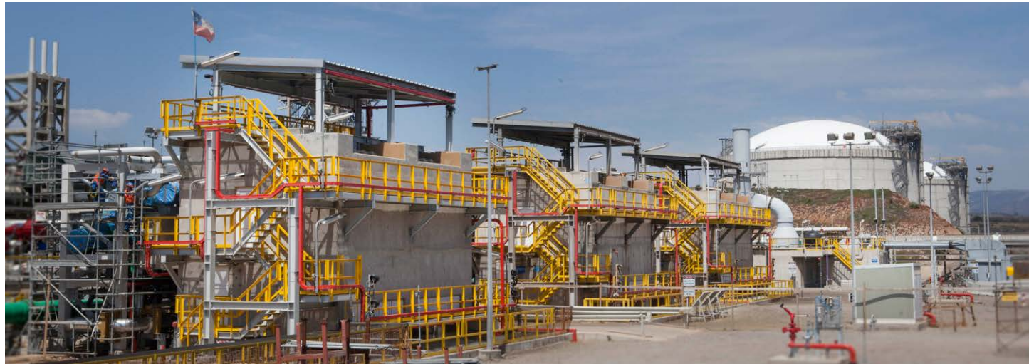
LNG regasification plant. Quintero (Chile).
