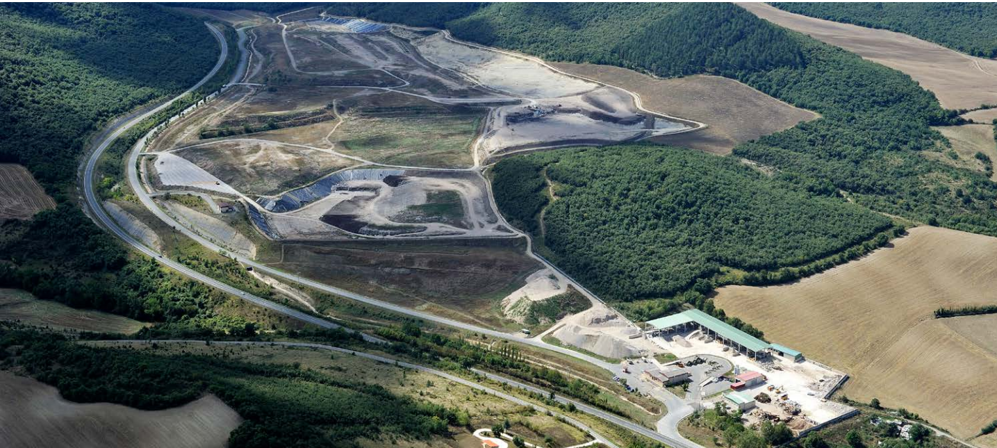
The Gardélegui solid waste landfill in (Vitoria, Álava).
