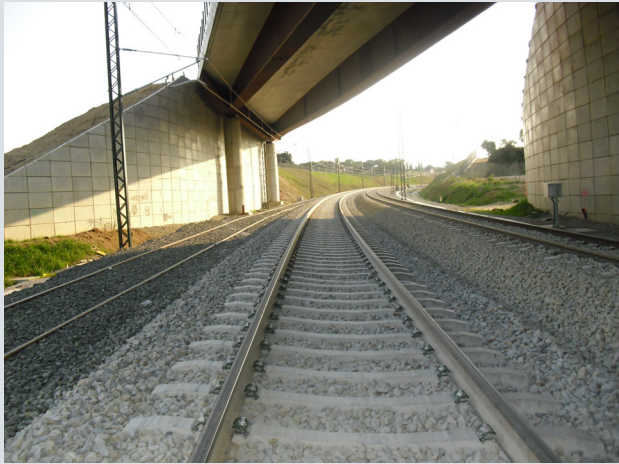
Traviesas monobloque pretensadas
