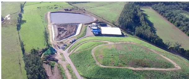
Desgasificación y restauración. Vertedero de Barbanza.
