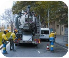
Limpieza de alcantarillado
