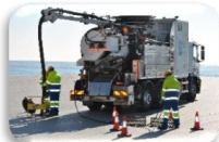
Servicio de limpieza y mantenimiento de alcantarillado
