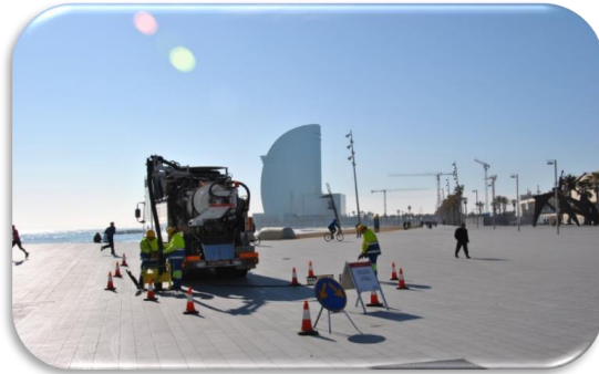
Proceso de limpieza de alcantarilla en litoral
