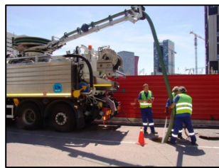
Servicio de Limpieza Alcantarillado
