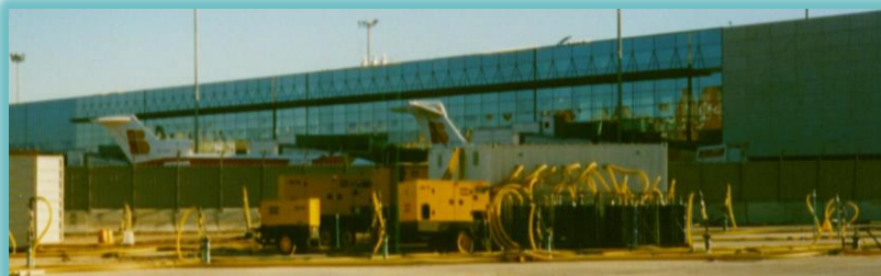
Recuperación del subsuelo del aeropuerto Madrid-Barajas
